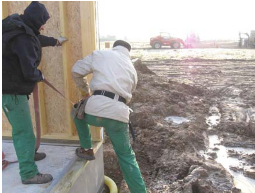
Abords de chantier...
