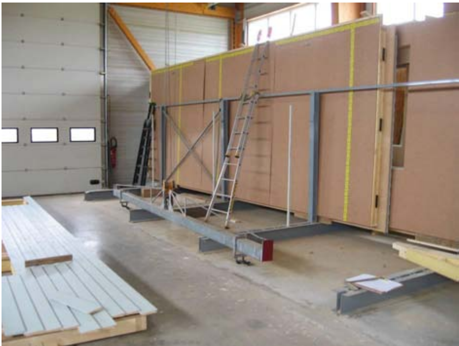
Stockages sur dépôt
